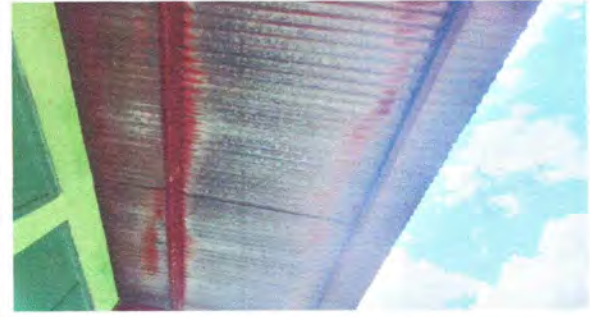
Foto 2: La sustitución de la cubierta de lamina se debe al deterioro que esta ha tenido por el paso de los años y que algunas laminas las ha levantado el aire.
